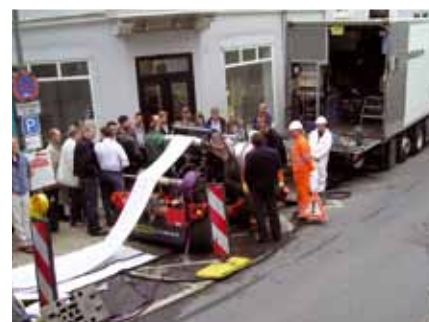
Kanalsanierung in Blankenese
