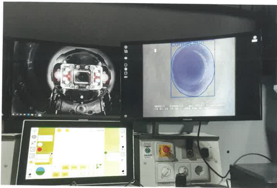
Bild 4 Der Einsatz von KI bei der Zustandserfassung von Kanalleitungen unterstützt die Netzbetreiber bei der digitalen Auswertung und Planung von Sanierungsarbeiten.
