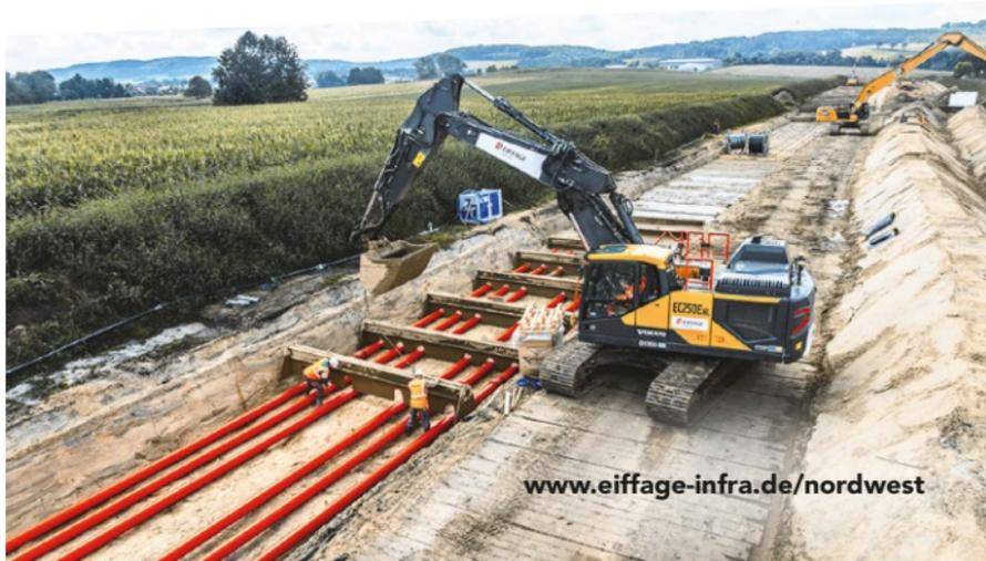
**Block 22 ZFSV (Flüssigboden) für die Fernwärmetrassen der Zukunft – eine echte technisch-ökologische Alternative**
