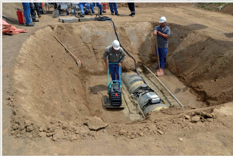
Bild 3: Pipelinerohr mit Sensorik bei seitlicher Verdichtung mit leichtem Verdichtungsgerät
