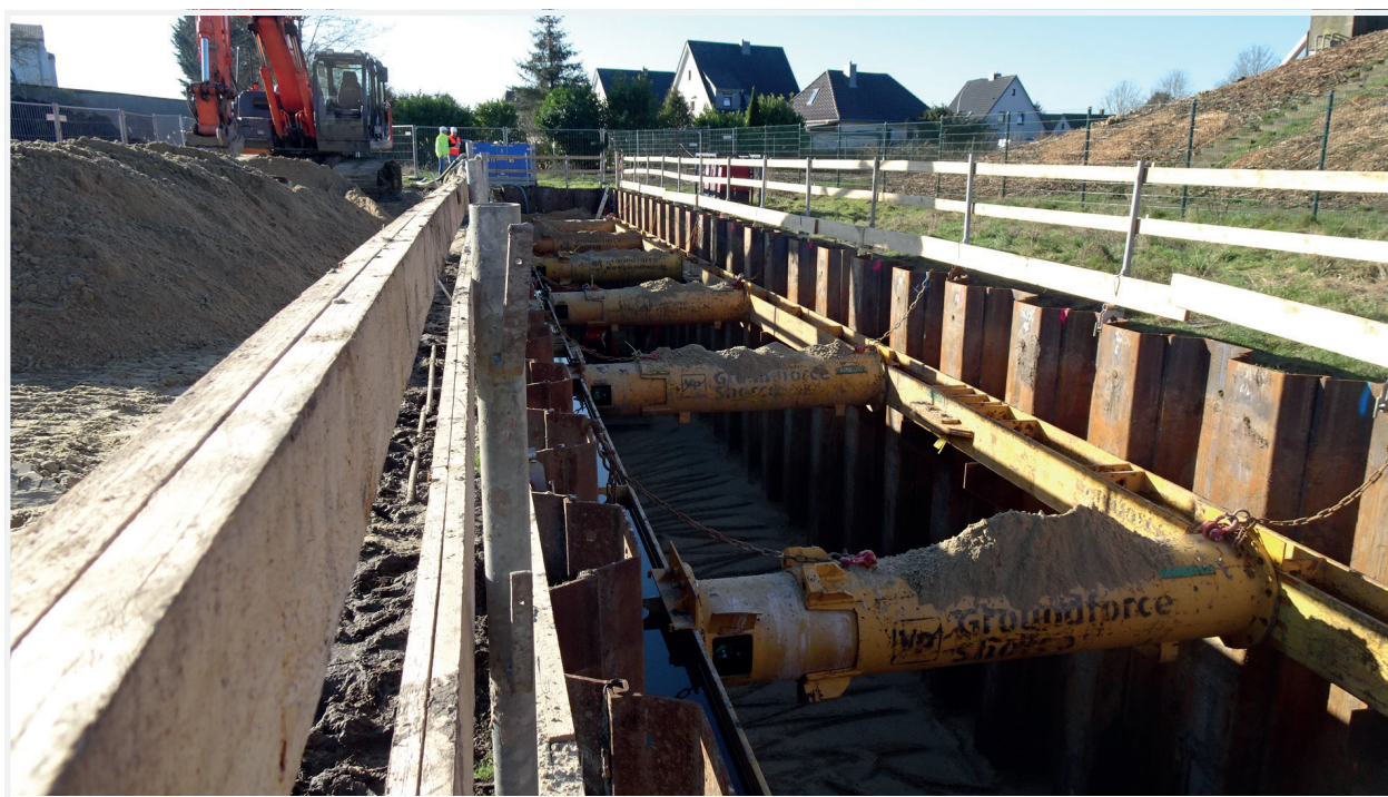
Laufende Tiefbaustelle (INGWA® 2023)
