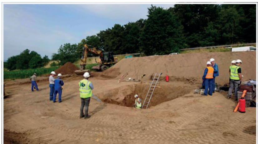
Bild 2: Versuchsbaustelle an der MERO-Pipeline in Würth an der Donau
