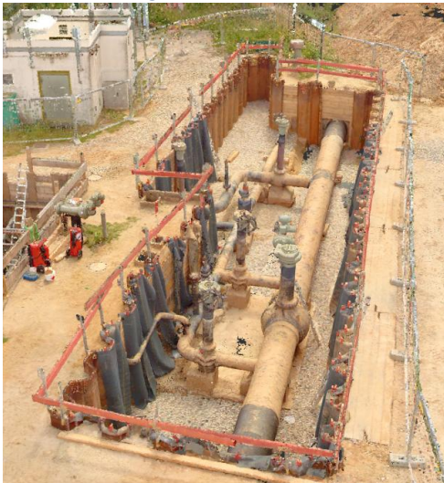
Abb.2 Auszug Schieberkreuz Bestandsleitung
