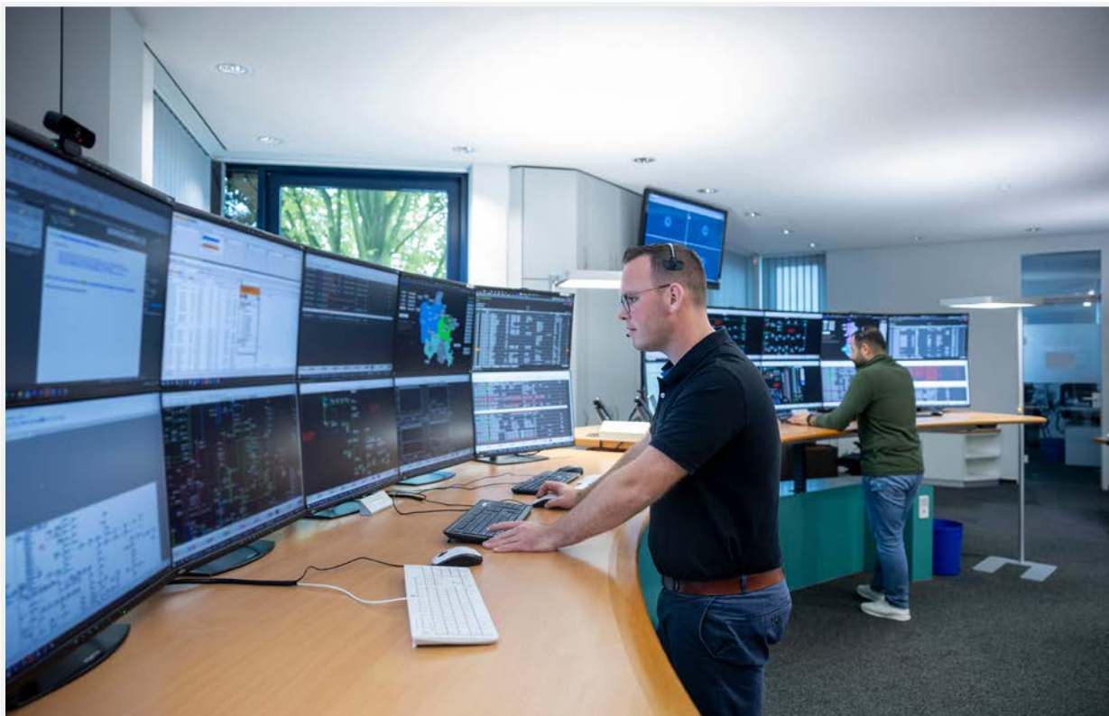
EWE NETZ Netzleitstelle Strom 115 Foto: Andreas Burmann
