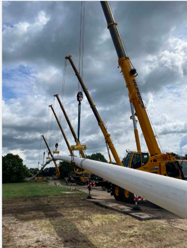
EWE Rohreinzug für ein HDD Bohrverfahren
