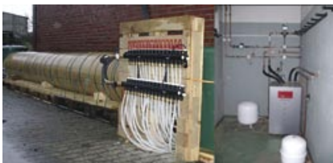
Abb. 1: Anschlussmontage Wärmetaucher.
